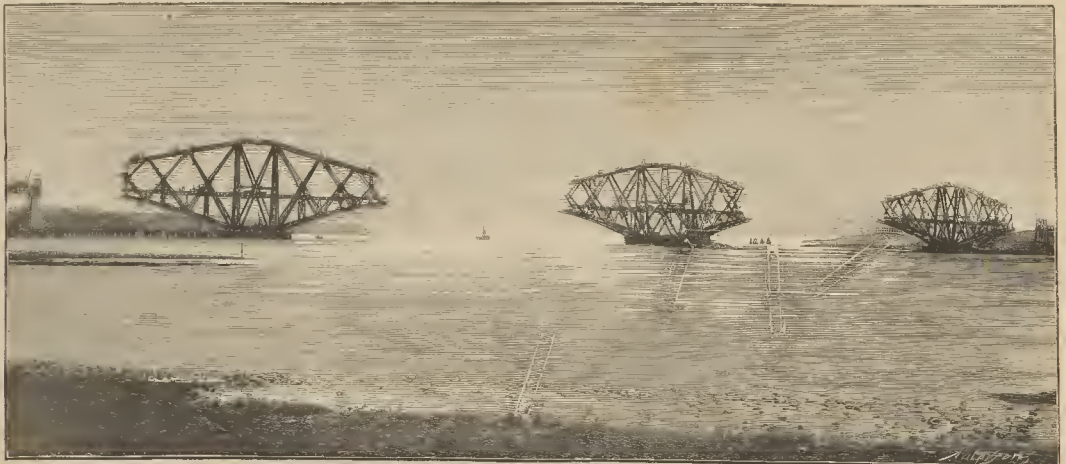
VISTA DEL PUENTE POR SU LADO ORIENTAL
